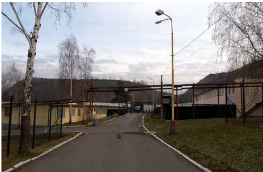
Tamtěř v r. 2009, vpravo budova kázeňských trestů (foto F. Bártík)
