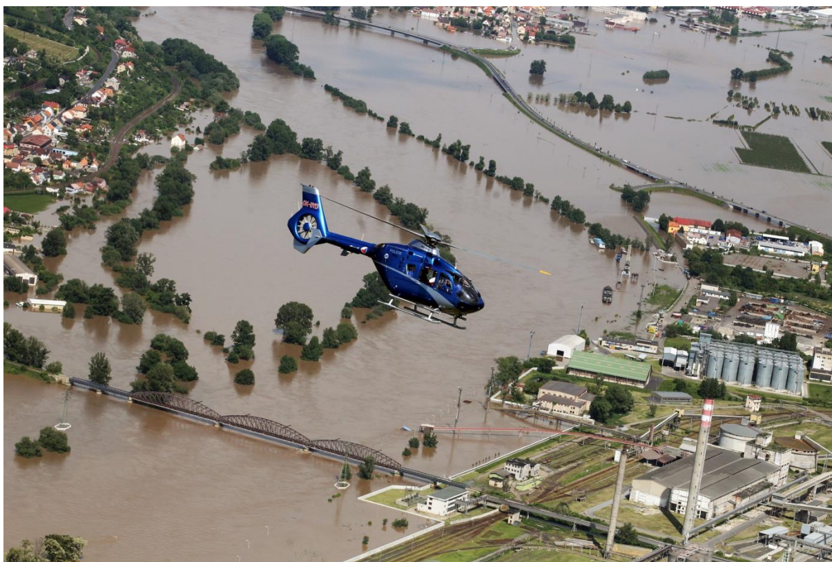
Kontrola protipovodňových hrází a možného průsaku vody v okolí chemičky LOVOCHEMIE
